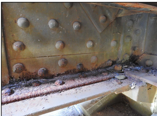
obr. 16: K 02 oslabení L hl. nosníku konec
