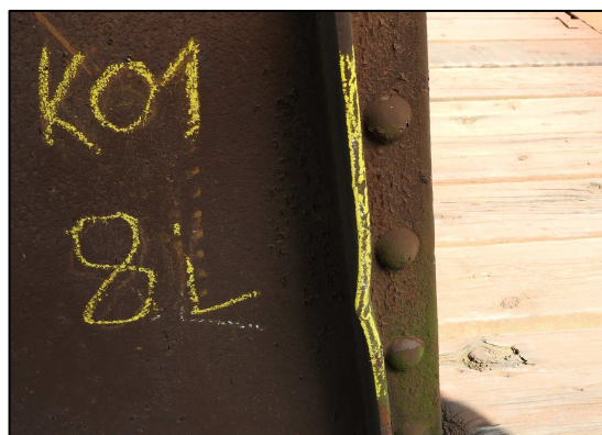
obr. 11: K 01 koutová výztuha u 8. svislice
