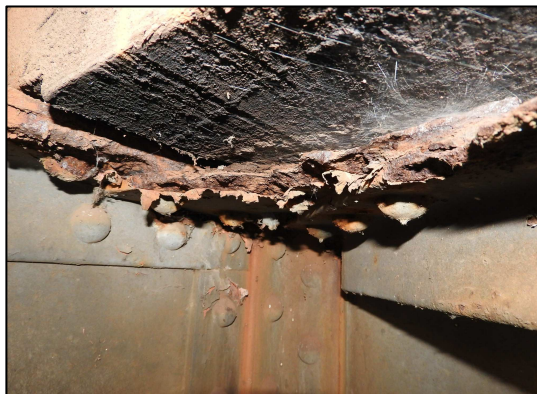
obr. 8: K 01 oslabení styčnickový plech pod. ztužení
