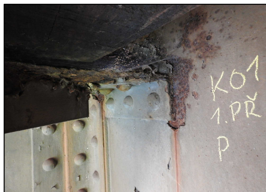
obr. 5: K 01 oslabení stojiny 1.PŘ/1.pole vpravo
