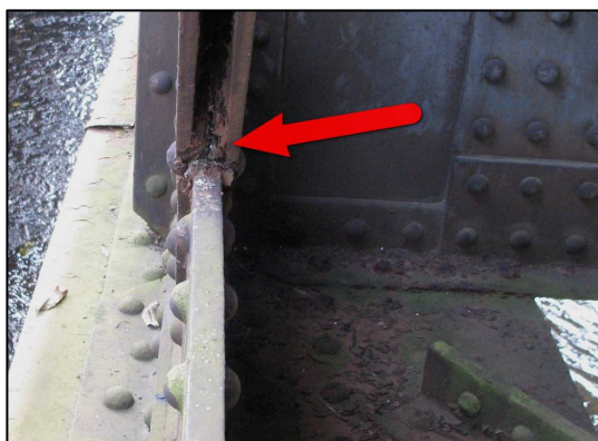
obr. 2: K 01 šterb. koroze v napojení diagonály
