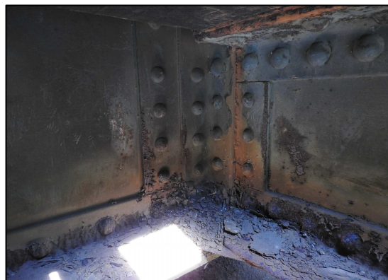
obr. 17: K 02 oslabení 11.PŘ u P podélníku
