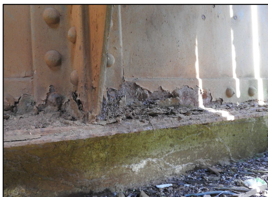
obr. 4: K 01 oslabení 1.PŘ/1.pole dolní příruba
