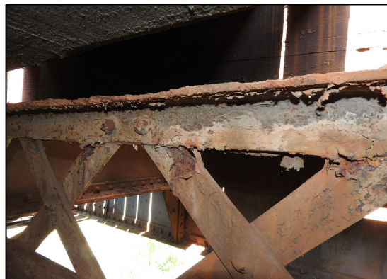
obr. 9: K 01 oslabení příčné ztužení podélníku
