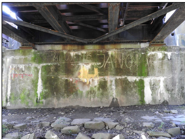
obr. 21: O 01 opěra pod K 02, průsaky vody a výluhy
