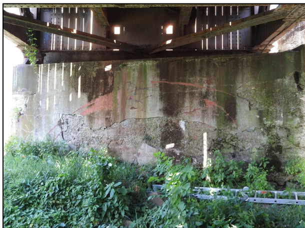
obr. 22: O 02 opěra pod K 01, degradovaný beton
