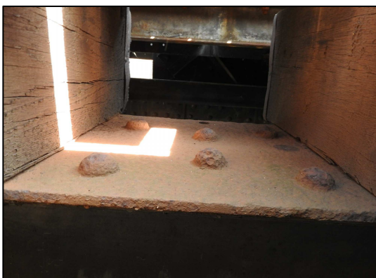
obr. 18: K 02 oslabení P podélník horní příruba
