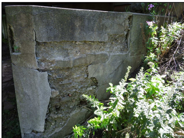
obr. 20: O 01 opěra zleva, značně degradovaný beton
