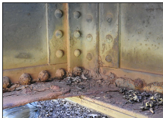
obr. 19: K 02 oslabení P podélníku u 1. PŘ
